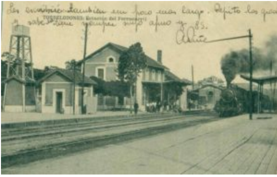
Estación de Torreldones 1926
