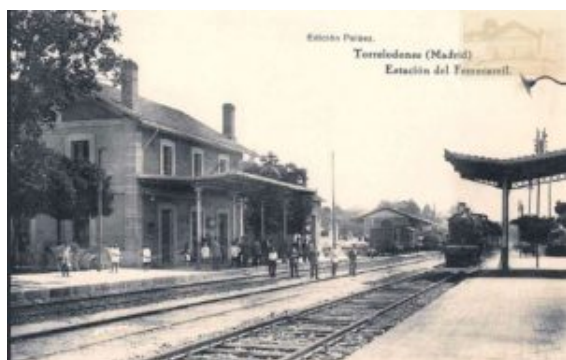
Estación Ferrocarril Torrelodones 1920. Gentileza Susana Garralda.
